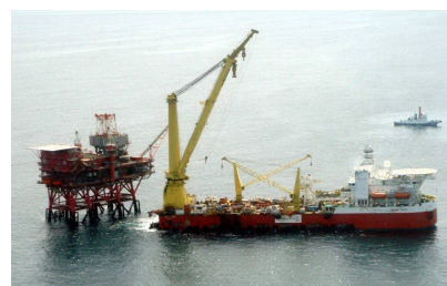
日本 太平洋岸 海上 油田掘削用 海上作業台 解体工事 英国とマレーシアよりの技術者間の調整
