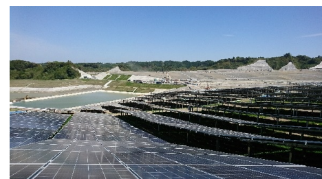
日本 九州 太陽光発電所 建設工事 ゴルフ場、塩田、等を改造
