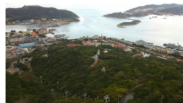
中国 東北部 旅順 港湾改修工事 埠頭と倉庫、等の建設
