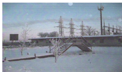
カザフスタン 首都上水道 設備工事 摂氏-35度での土木工事管理
